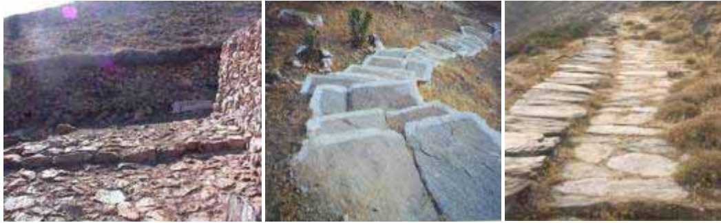
Φωτογραφίες τρίτης κατηγορίας: Πλακόστρωτη αυλή μαντριού στην Πάτμο, πλακόστρωτο μονοπάτι στην Άνδρο (Φωτ. Τίτου Γιοχάλα) και πλακόστρωτο μονοπάτι στην Λέσβο.
